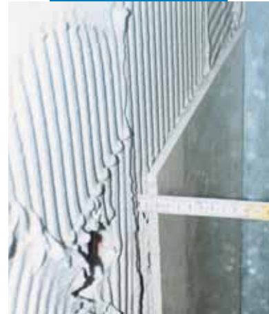
Ansetzen von Feinsteinzeug an der Wand
